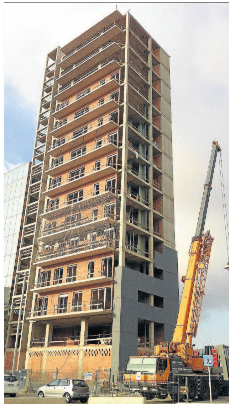
Edificio en construcción en Parc Central de Torrent. LEVANTE-EMV
