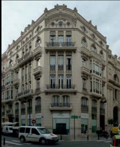
Los edificios de la Reforma Interior pasan de tener cuatro alturas a generalmente seis, al tiempo que se extiende el uso de los chaflanes. Calle Correos 4 esquina con Pérez Pujol 8ac
