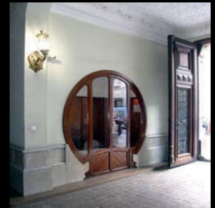
Los zaguanes se cargan de decoración vegetal en falsos techos, frisos, vidrieras, pinturas... y aparecen eventualmente vanos ultrasemicirculares. Calle Comedias 7 (1905) de los arquitectos Enric Sagnier y Francisco Mora
