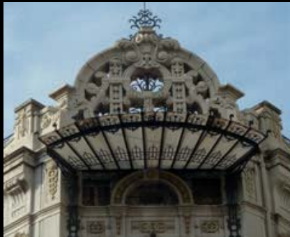
En los edificios más significativos aparecen las marquesinas metálicas acristaladas, adornadas con follaje, guirnaldas, triglifos... Calle Barcas 4 esquina con Pérez Pujol 2 (1910) del arquitecto Luis Ferreres
