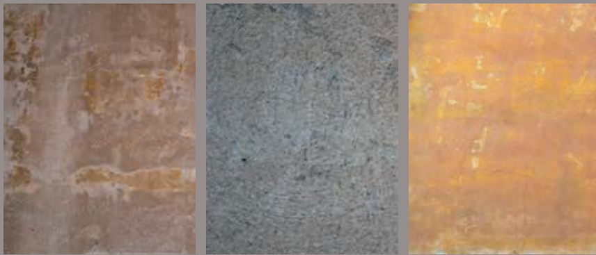
De izq. a der.: Aspecto de un revoco liso. Aspecto de un revoco liso lavado. Aspecto de un revoco liso estucado (La Spina)
