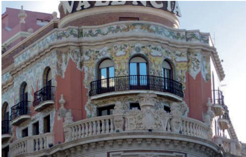
Banco de Valencia. Esquina de las calles Pintor Sorolla y Don Juan de Austria (1934-1942). Arquitectos: Antonio Gómez Davó y Juan Traver
