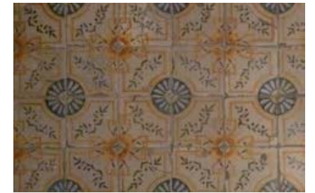
Pavimento del Colegio del Patriarca
