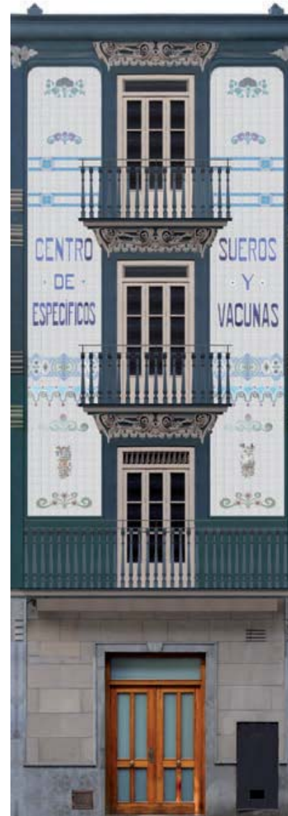
Fotoplano de la fachada de la calle Trench 25, completamente alicatada de azulejos a principios del siglo XX
