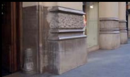
Los zócalos de piedra combinan la molduración clásica de escocias, cintas y bandas con texturas variadas (abujardada, verrugada, lisa...) en busca de mayor expresión. Calle Paz 31 (1903) de los arquitectos Enric Sagnier y Francisco Mora
