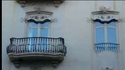
Las ventanas pueden llegar a adoptar formas libres sinuosas de diverso tipo y los guardamalletas se convierten en un elemento más para el diseño imaginativo de la fachada. Calle Mar 42 (1902) de los arquitectos Enric Sagnier y Francisco Mora
