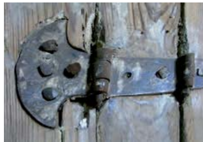
Bisagra de doble nudo. Detalle carpintería de una ventana del Palacio en la calle Portal de la Valldigna 4 (siglo xviii)
