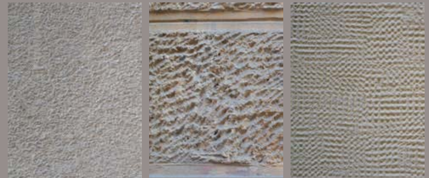
De izq. a der.: Aspecto de un revoco rugoso pétreo. Aspecto de un revoco rugoso rústico o labrado. Aspecto de un revoco rugoso a la martellina (La Spina)
