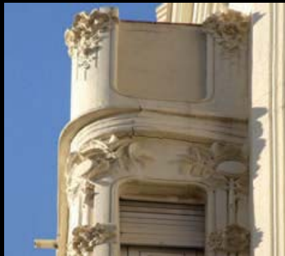
Se utiliza profusamente la piedra artificial a base de cemento para la fabricación de los motivos decorativos del edificio que a menudo son de inspiración floral o vegetal. Calle Roterros 1 esquina con Serranos 33ac
