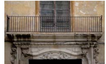
Palacio Lassala. Calle Calatrava 13
