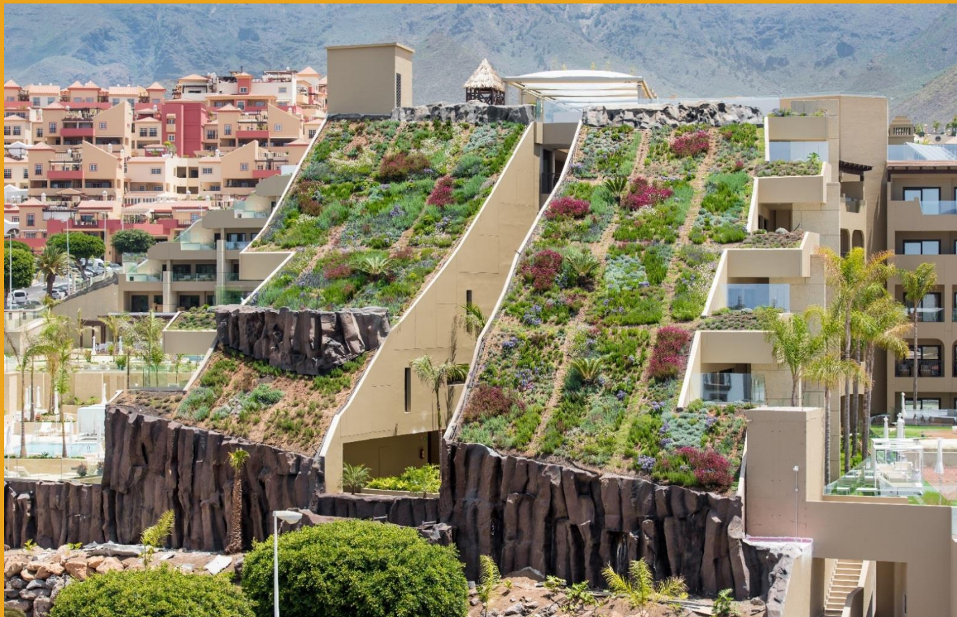
Foto: Ganador de La Mejor Obra 2018 / Cubierta Vegetal
