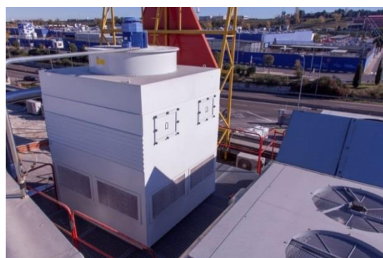
Nuevas torres de enfriamiento para producción de polímeros en la planta de Alcobendas (España)
