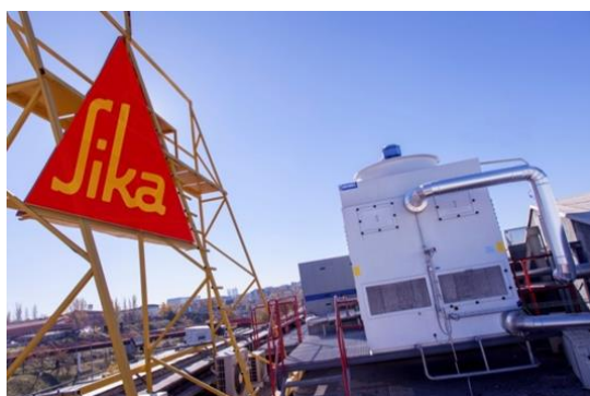
Nuevas torres de enfriamiento para producción de polímeros en la planta de Alcobendas (España)
