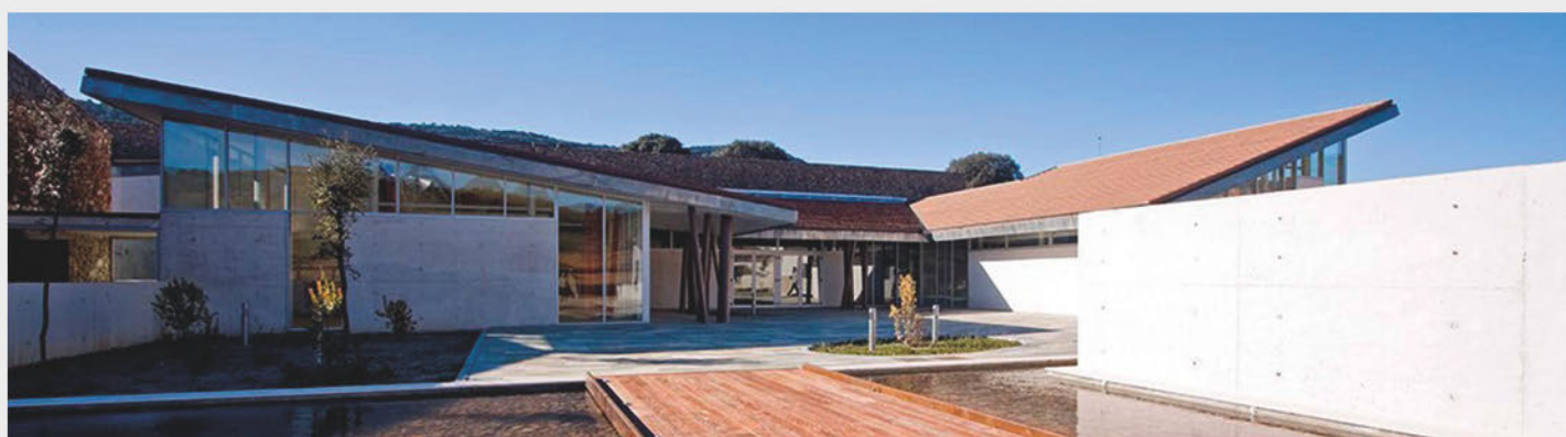
Figura 44 Obras con fojado cerámico revestido en la arquitectura moderna. Centro de Visitantes y Museo Interactivo P.N. de Cabañeros, Horcajo de los Montes, Ciudad Real. Álvaro Planchuelo
