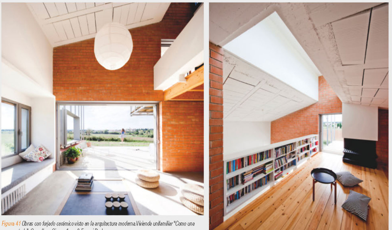
Figura 40 Obras con forjado cerámico visto en la arquitectura moderna. Casa Anoro. Sant Esteve de Palautordera, Barcelona. Anna & Eugeni Bach
