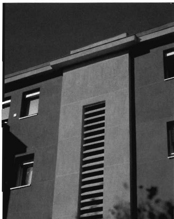
Se trata de solución idónea para obra nueva y para rehabilitación
